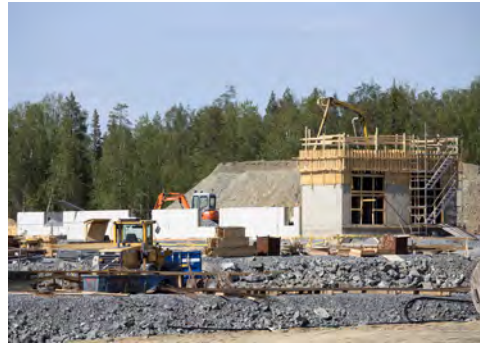
Sulfaatinpoistolaitoksen rakennustyömaa kesäkuun alussa. Laitoksen investointi on noin 19 miljoonaa euroa.
