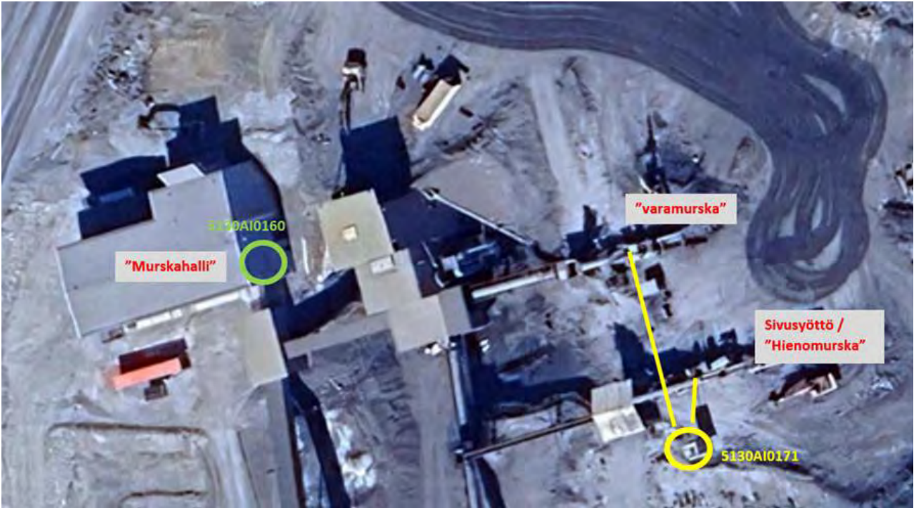
Kuva 13. Murskainten sijainnit ja poistokaasun hiukkaspitoisuusmittausten mittausspaikat murskahallin käyttöönoton jälkeen.
