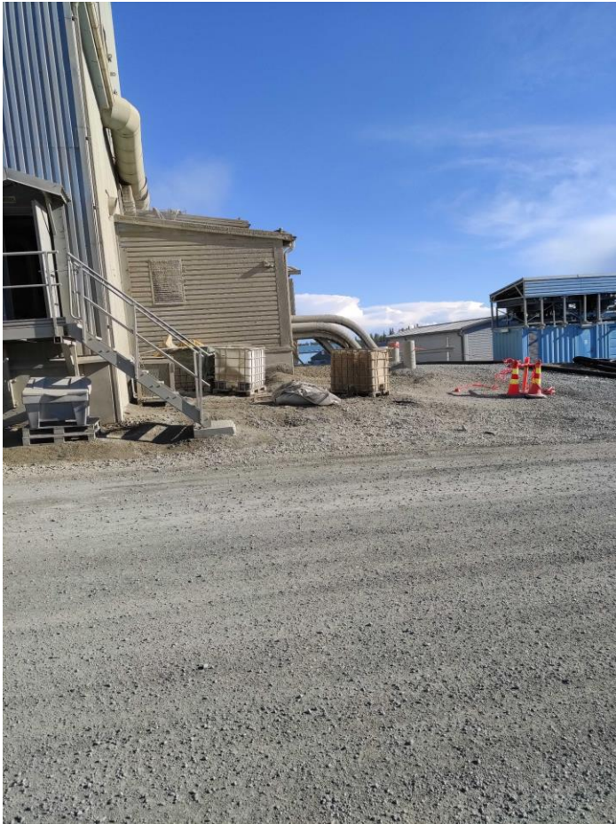
A, rakennuksessa tehtiin kunnossapitotöitä mittausten aikaan.
