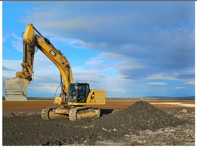
Kuva 12. Louhetäyttö on kiilattu pienlouheella (22.10.2024).
