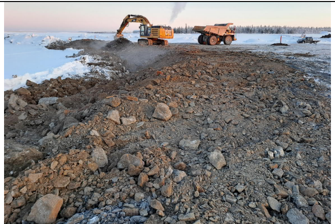
Kuva 2. Sullottua louhetta FP4 loholla (11.1.2024).
