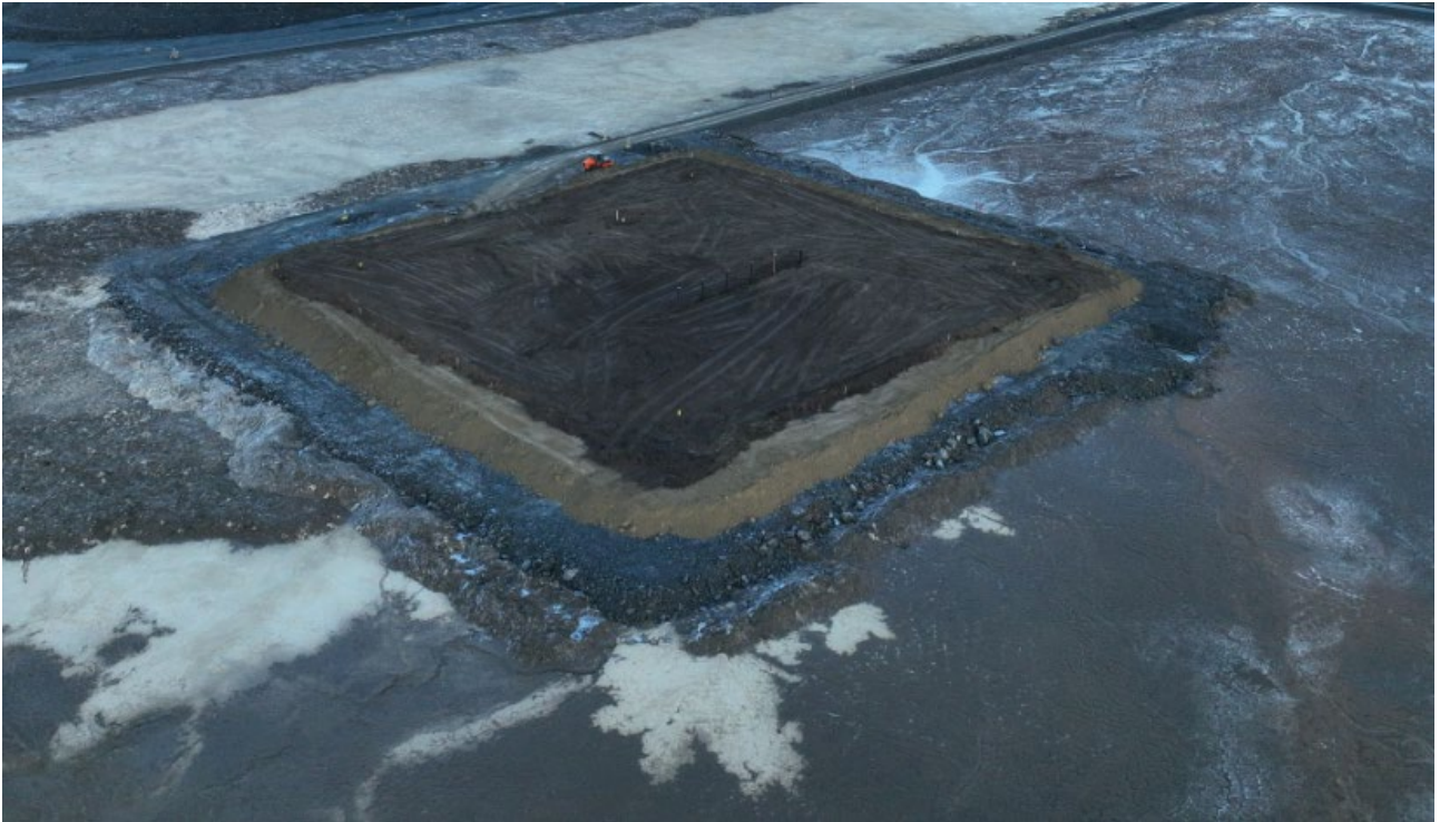
Kuva 4. Rakenteen PF2-osalta viimeisiä rakennekerroksia viimeistellään.
