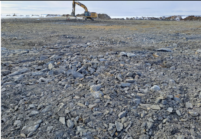
Kuva 7. Rakenne on tiivistynyt hyvin ja kantavuuspuutteita ei ole havaittu (27.3.2024).
