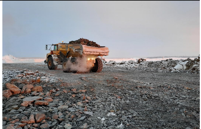
Kuva 6. Rakenne tiivistetään työmaaliikenteellä täyteen lastatuilla kiviautoilla (18.1.2024).
