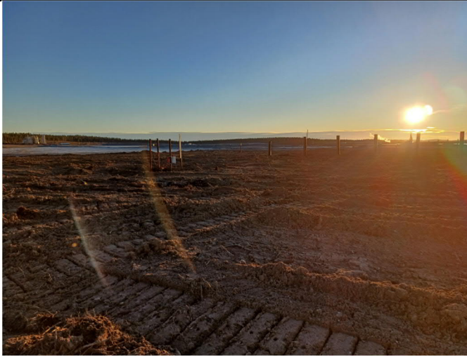
Kuva 16. Kasvukerros on tiivistetty tela-alustaisella työkoneella (14.11.2024).
