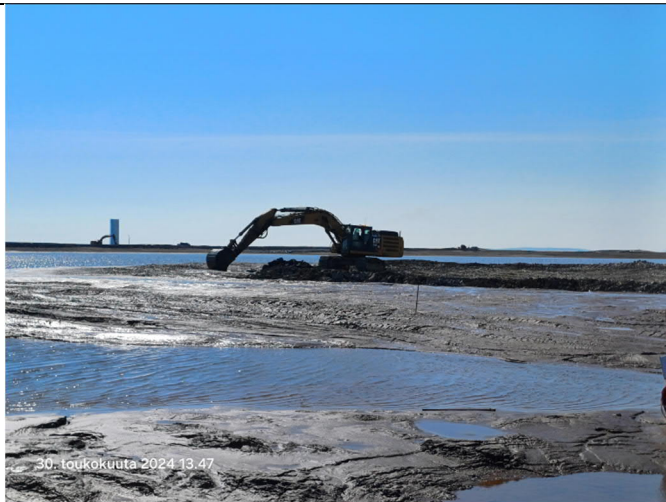
Kuva 1. Louheen sullontaa FP5 loholla (30.5.2024).
