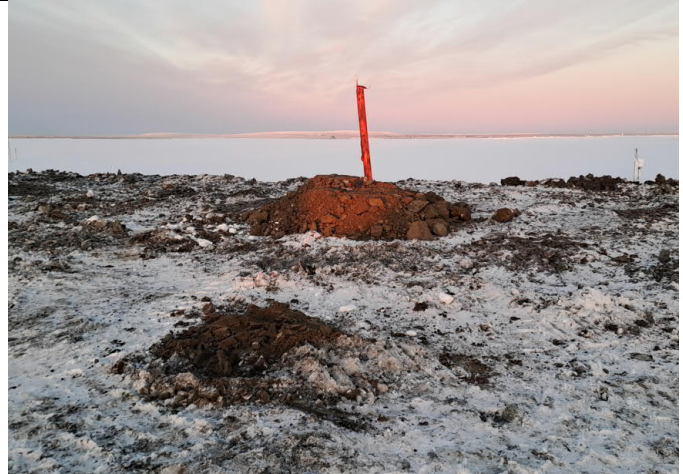
Kuva 8. Alueelle on asennettu painumatankoja, joilla mitataan louhepenkereen painumaa (11.1.2024).
