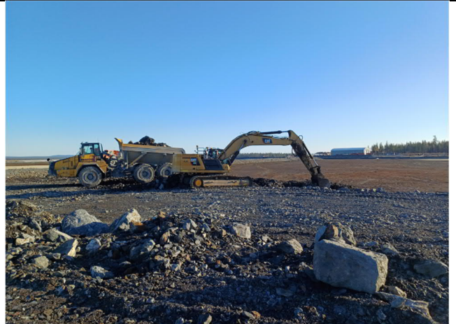
Kuva 4. Louhe sullotaan rikastushiekkaan kaivinkoneen kauhalla painamalla. (7.10.2024).
