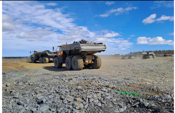
Kuva 6. Rakenne tiivistetään työmaaliikenteellä täyteen lastatuilla kiviautoilla (15.5.2024).
