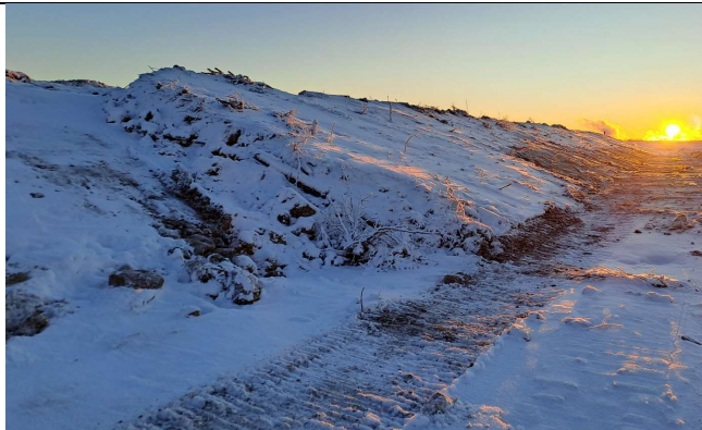
Kuva 5. Rakennettavaa kasvukerrosta loholla FP2 (27.11.2024).
