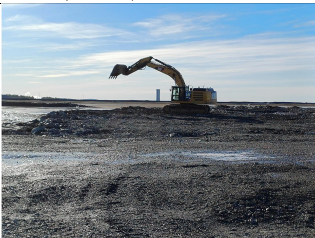
Kuva 7. Rakenne on tiivistynyt hyvin ja kantavuuspuutteita ei ole havaittu (30.9.2024).
