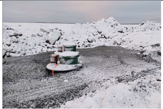
Kuva 2. Purkukaivon ympäristäytön materiaali oli silmämääräisesti arvioituna suunnitelmien mukaista (20.11.2024).
