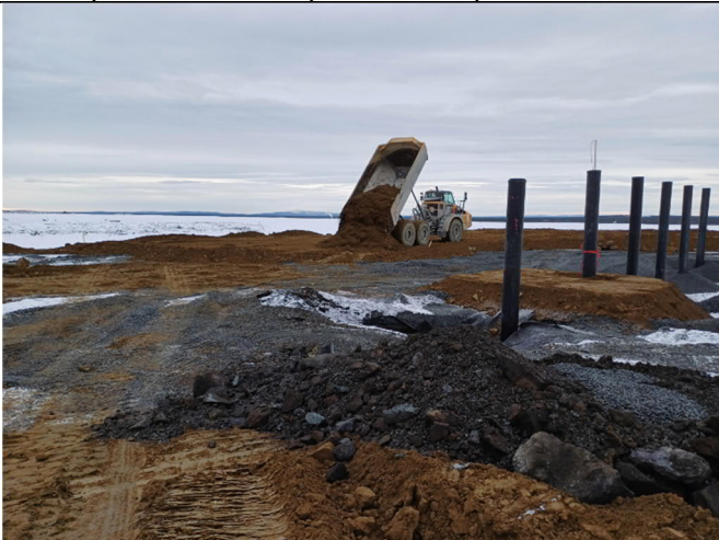
Kuva 14. Moreenikerros on rakennettu ja tiivistetty kerroksittain. (6.11.2024).
