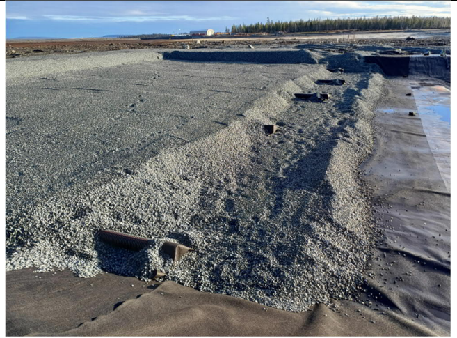
Kuva 10. Lysimetriin on asennettu salaojaputket. (22.10.2024).
