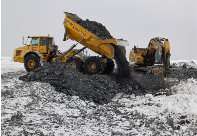
Kuva 1. Sivukivitäytön rakentamista FP3 loholla (21.2.2024).
