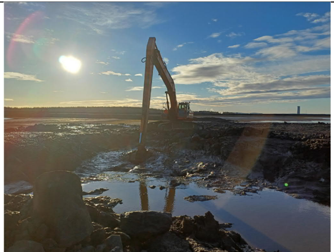
Kuva 2. Märän rikastushiekan läjitystä FP5 loholla (22.10.2024).
