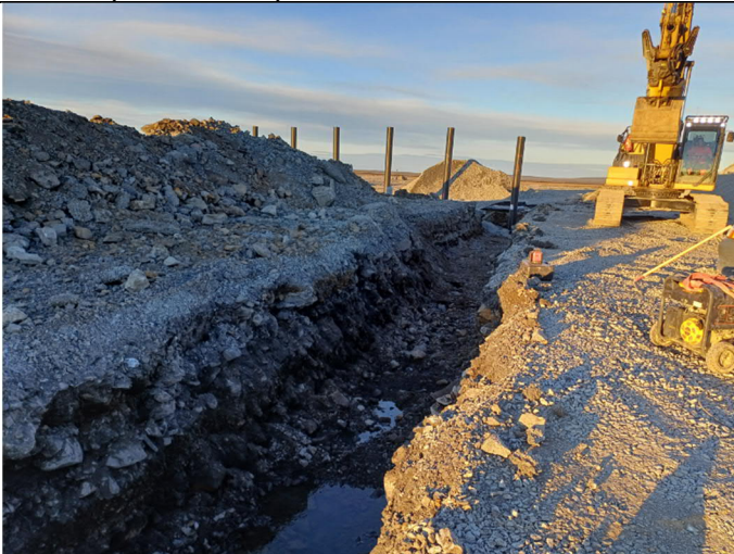
Kuva 11. Putkikaivanto putkiasennukselle vedenpostoa varten. (14.11.2024).
