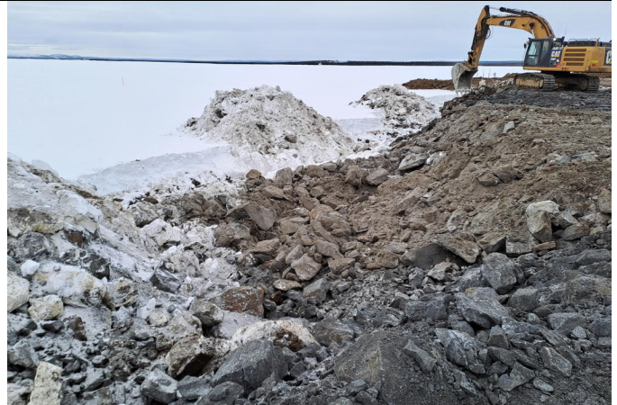
Kuva 2. Sullottua louhetta FP1 loholla (31.1.2024).
