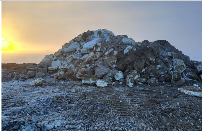
Kuva 1. Jäätynyt rikastushiekka ja sulfaatinpoistolaitoksen jäätynyt alite on poistettu ennen louheen sullontaa (18.1.2024).
