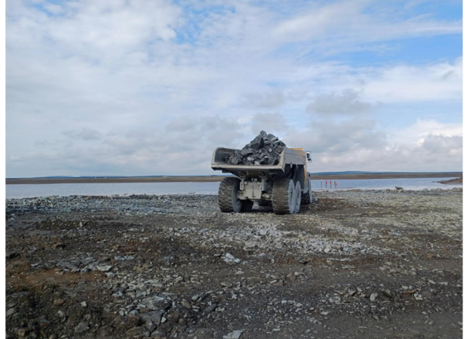
Kuva 6. Rakenne tiivistetään työmaaliikenteellä täyteen lastatuilla kiviautoilla (28.5.2024).
