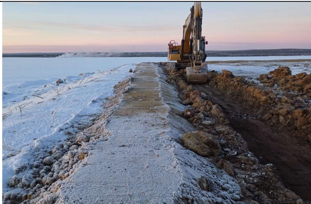
Kuva 7. Moreenipenkereen ja avopainanteen rakentamista loholla FP2 (4.12.2024).
