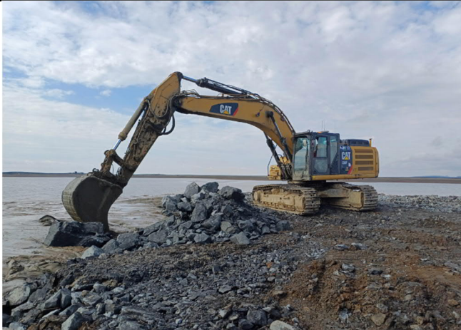
Kuva 3. Rikastushiekan koostumus on vaihdellut alueittain. Lohkolla FP5 rikastushiekka on ollut vetistä ja syrjäytynyt selkeästi. (28.5.2024)
