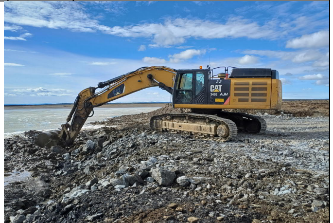
Kuva 4. Louhe sullotaan rikastushiekkaan kaivinkoneen kauhalla painamalla (13.5.2024).
