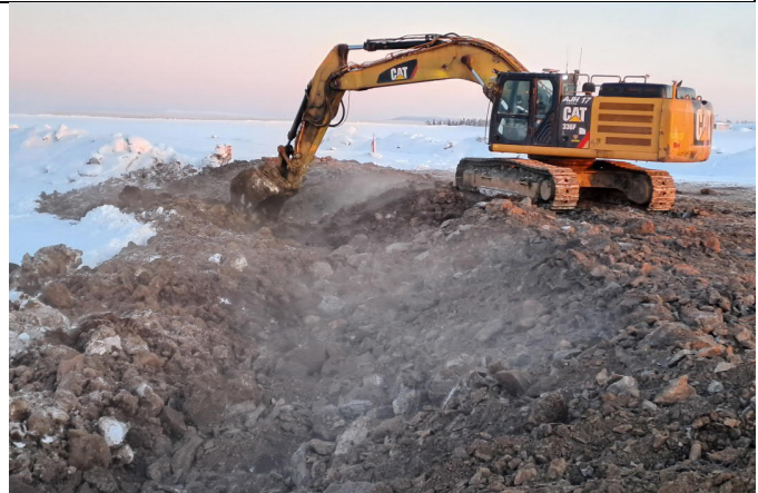
Kuva 4. Louhe sullotaan rikastushiekkaan kaivinkoneen kauhalla painamalla (11.1.2024).
