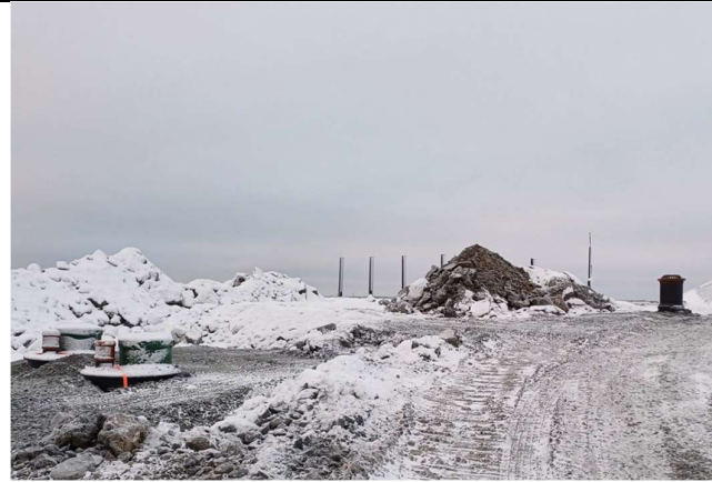
Kuva 1. Lohkolle FP4 on asennettu purkukaivot (20.11.2024).
