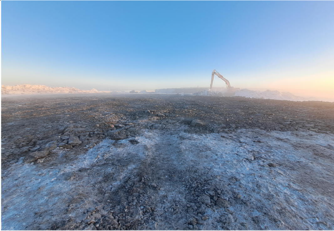
Kuva 7. Rakenne on tiivistynyt hyvin ja kantavuuspuutteita ei ole havaittu (25.1.2024).
