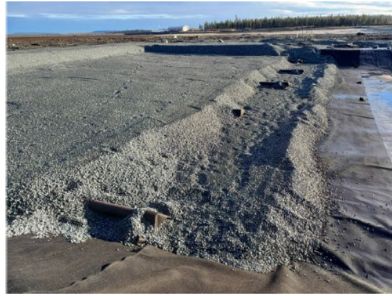
Kuva 3b. Bitumigeomembraanin päälle on asennettu suojageotekstiili ja täyttö tehdään 8-16# mm sepelillä. Sepelin seassa näkyy keruuputkisto, minkä tarkoituksena on parantaa lysimetrin toimintaa.
