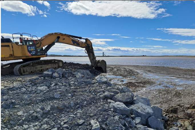
Kuva 3. Rikastushiekan koostumus on vaihdellut alueittain. Lohkolla FP5 rikastushiekka on ollut vetistä ja syrjäytynyt selkeästi. (15.5.2024)
