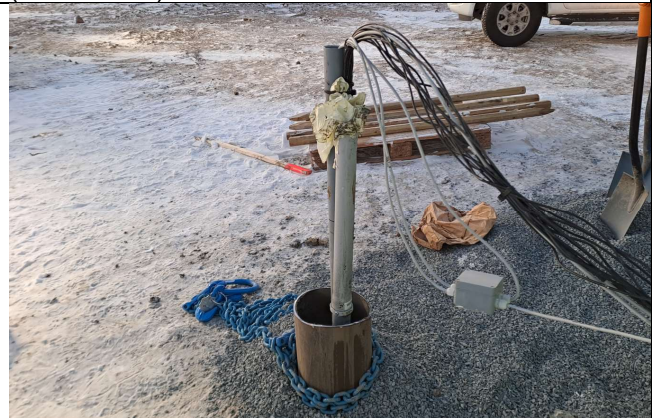
Kuva 8. Instrumentointien asentamista loholla FP2 (12.12.2024).
