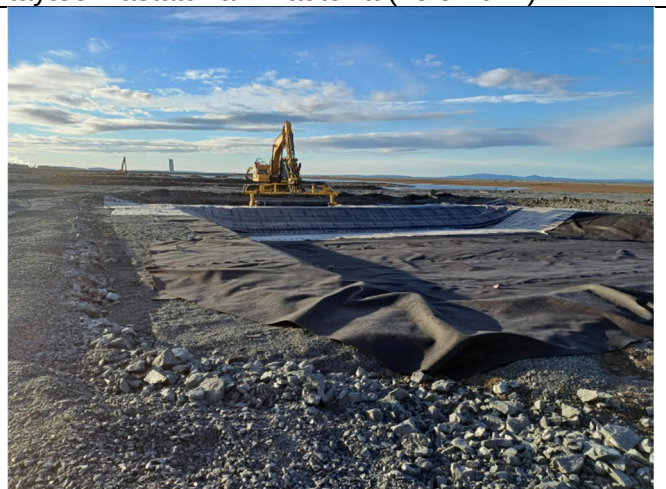
Kuva 8. Murskeen päälle on asennettu suojageotekstiili sekä bitumigeomembraani. (22.10.2024).
