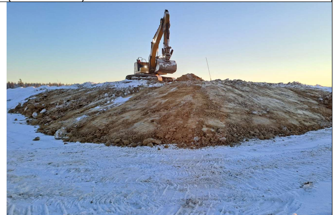
Kuva 4. Moreenikerros on rakennettu ja tiivistetty kerroksittain. (27.11.2024).
