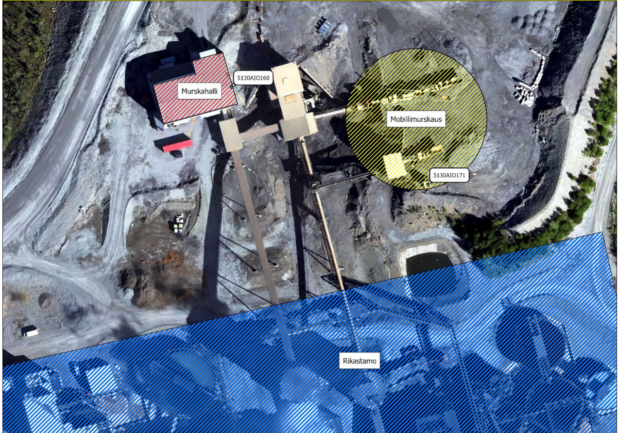
Kuva 15. Murskainten sijainnit ja poistokaasun hiukkaspitoisuusmittausten mittauspaiikat.
