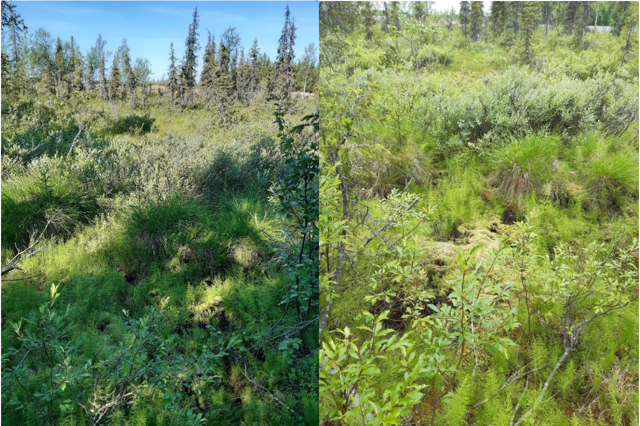
Kuva 2. Etualalla tihkupinta, taustalla lettoräme ja taka-alalla uutta rakenteilla olevaa tietä kesällä 2023 (vasen) ja 2024 (oikea)
